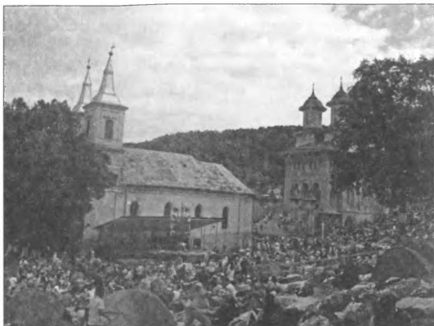
Estrada și instalația de sonorizare aferentă. Dispunerea circulară a pelerinilor.
