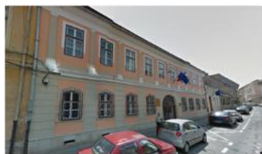
Clădirea „Brătianu” Str. I.C. Brătianu 22
